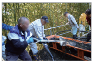
洗い終わった砂利を濾過槽に戻し終えたら、ベルトコンベアを洗うために鉄柵に立てかける。重い
