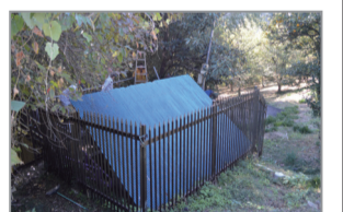
濾過槽は山の斜面にある。写真は蓋を開けた状態
